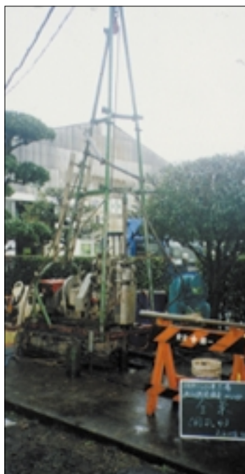
調査井戸掘削風景
