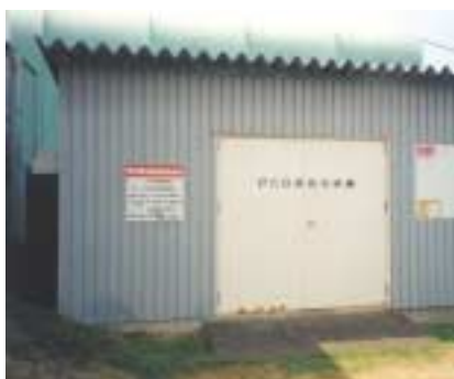
PCB含有製品保管庫
