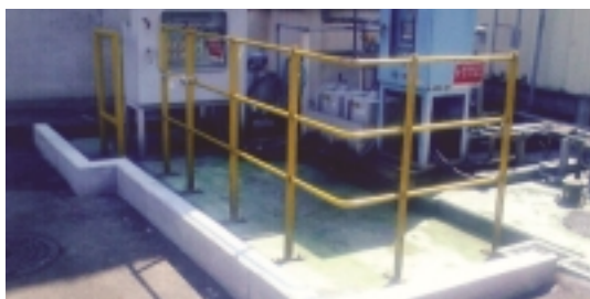
工程系廃液処理施設の防液堤設置(相模工場)
