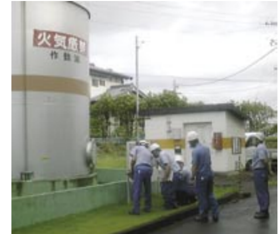
貯油施設の現場監査の様子
