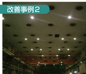
工場の天井灯を高効率低電力型に交換(相模・御殿場工場) 効果:CO 2 排出量を平均22%削減 63千kWh/年削減 24(t-C)/年削減
