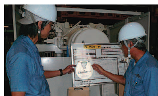
掲示板による進捗状況の確認
