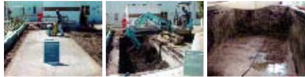
埋設保管状況
