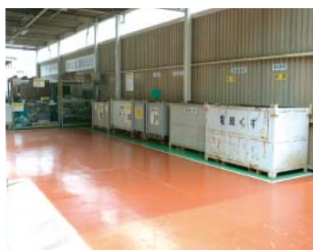
廃棄物ステーションの整備
