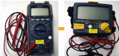
ヒータの絶縁確認 電圧、電流確認
